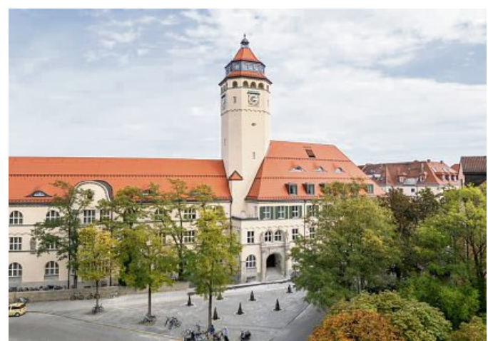
Eine Station bei den Architektouren: das frisch renovierte Oskar-von-Miller-Gymnasium.
