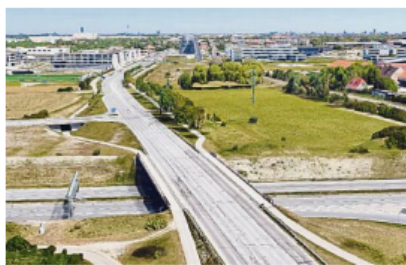
An der A99 sollen beim sechsspürigen Ausbau auch Radwege entstehen.
