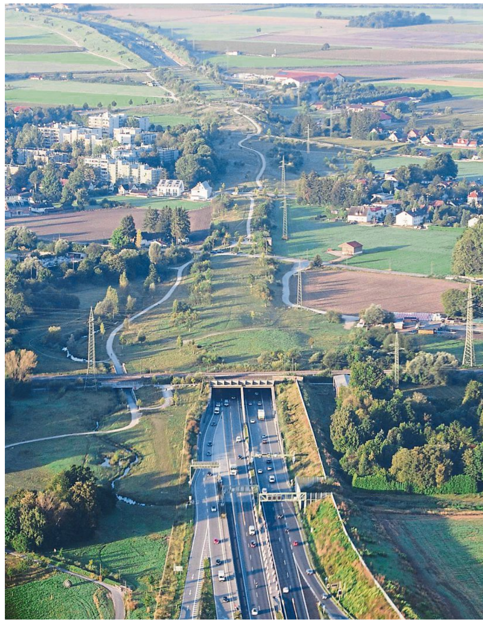
Enge Nachbarschaft: Bei einem Ausbau des Allacher Tunnels wären einige Häuser vom Abriss bedroht. FOTO: BODMER
